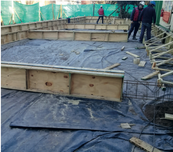
Foto 10.24. Aislamiento del piso para una cámara frigorífica.
